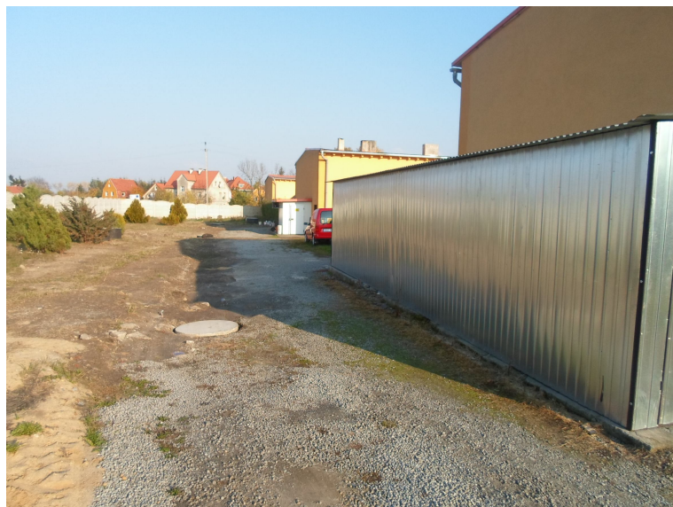
Fot. nr 3 – Stan istniejący ciągów pieszo-jezdnych – od strony północnej zabudowań.
