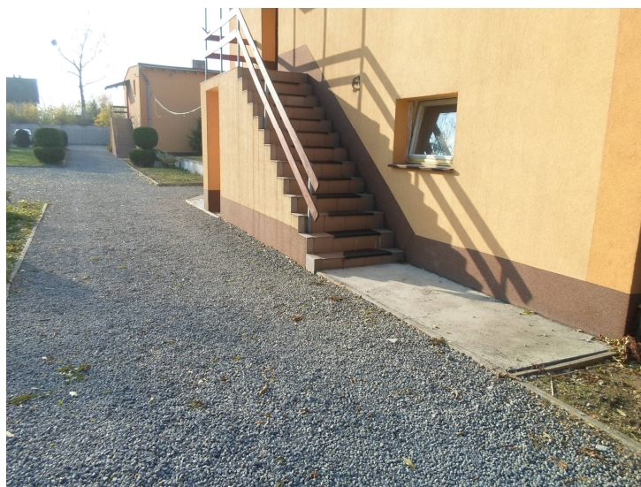
Fot. nr 1 – Stan istniejący ciągów pieszych – dojść do zabudowań.
